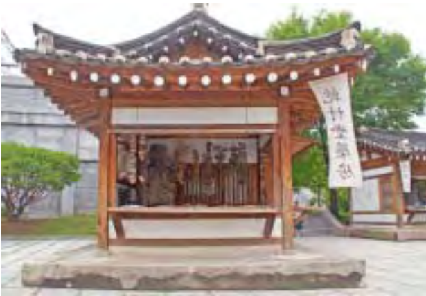
昔の薬房を再現した建物
