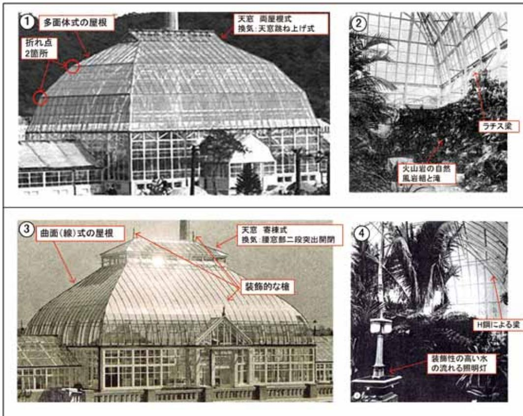
図11 東山植物園と宝塚植物園の温室中央ドームの写真比較。①：東山植物園温室の外観（東山植物園所蔵）。②：東山植物園温室の内部構造（野間 1937）。構造材はL形鋼によるラチス梁。③：宝塚植物園温室の外観（著者蔵絵葉書より）。④：構造材はH形鋼の曲げ加工（実際園藝編集部 1930）。
